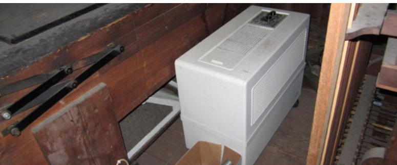
Luchtbevochtiger met vaste wateraansluiting en een luchtbevochtiger in een orgel
