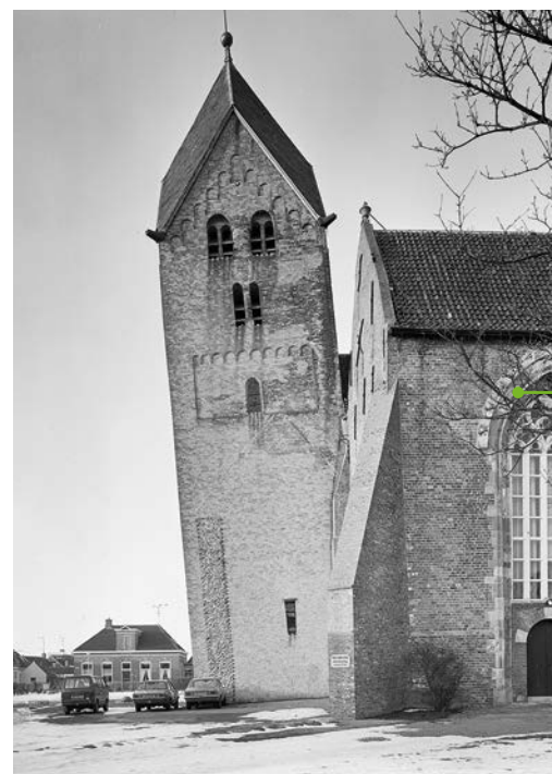
De tufstenen toren van Bedum.
